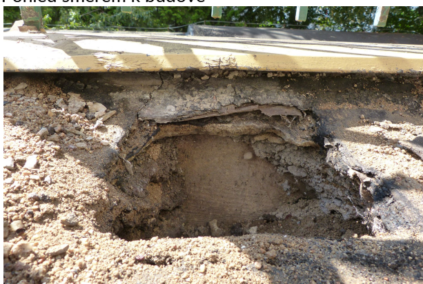
Sonda do konstrukce pláště
