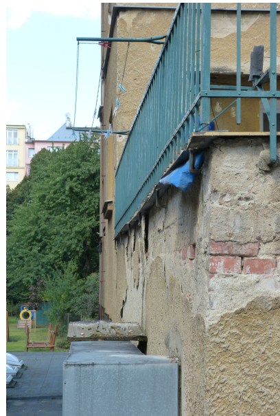
Oplechování atiky a kotvení zábradlí
